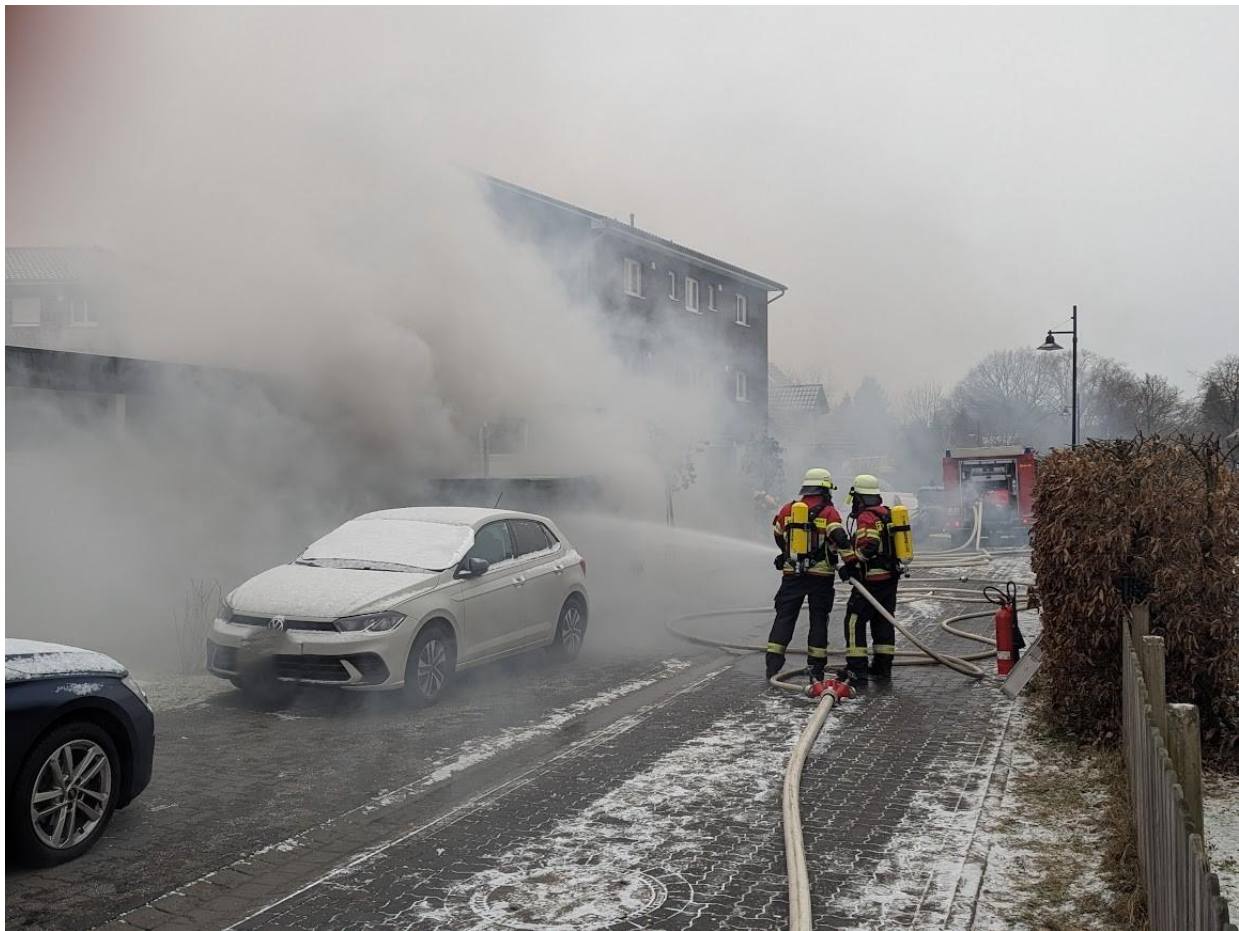
Einsatzkräfte unter Atemschutz beim Ablöschen der Trafostation
