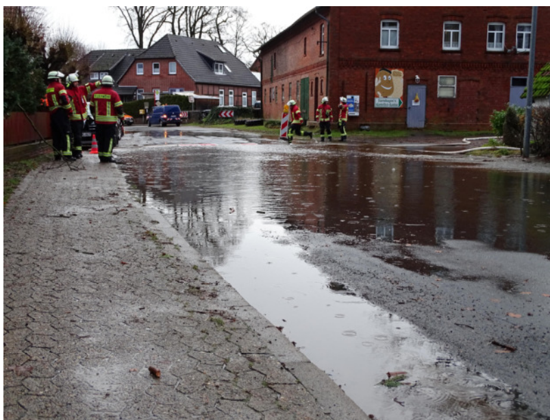
Bild: Überlaufener Dorfteich in Quarrendorf
