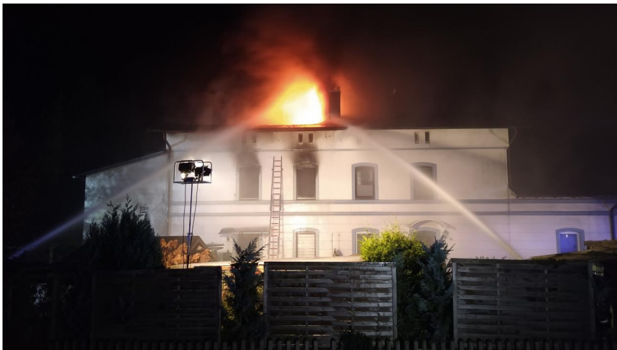
Das Mehrfamilienhaus in der Straße „An der Bahn“ in Marxen wurde teilweise zerstört – Bewohnerin weiterhin vermisst.
